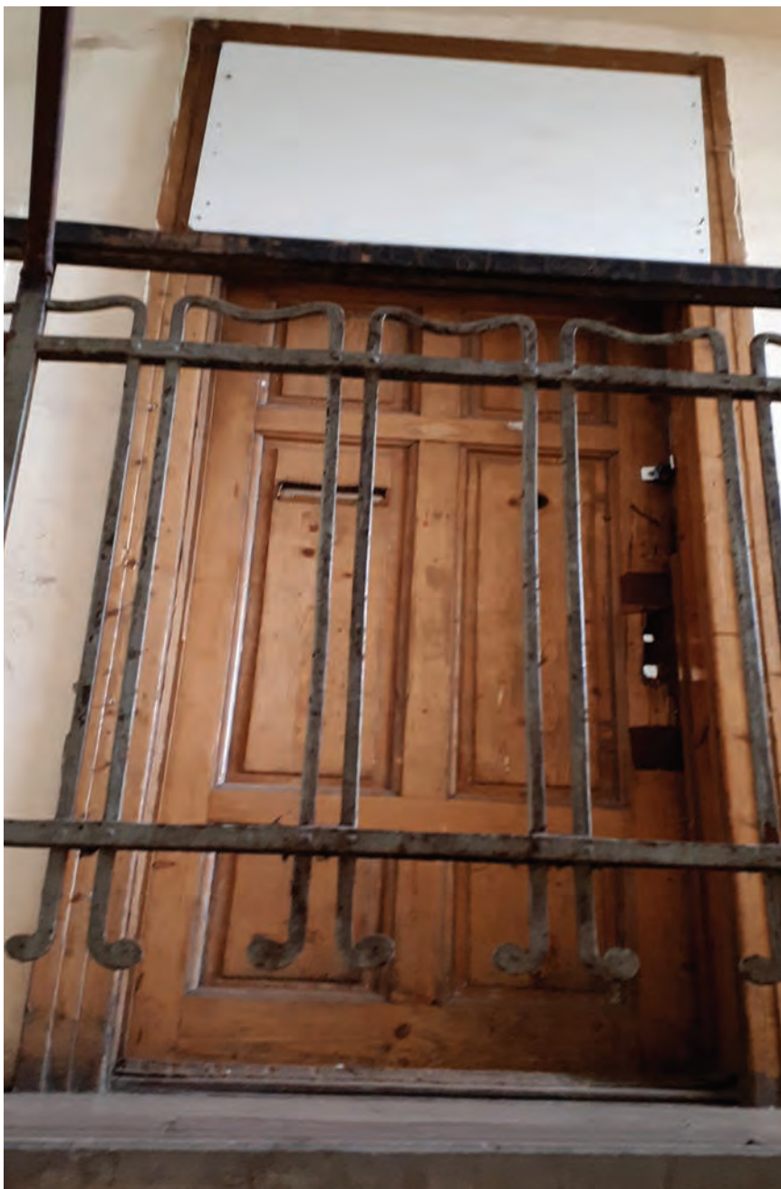
Brněnské byty "Housing first"
